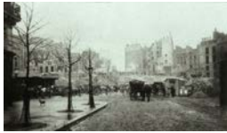
Charles Marville Demolición de la Butte des Moulins para la Avenue de l'Opéra , 1870 Brown University Library
