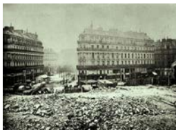
P. Emonts Demolición de la Butte des Moulins para la Avenue de l'Opéra , 1870 Brown University Library
